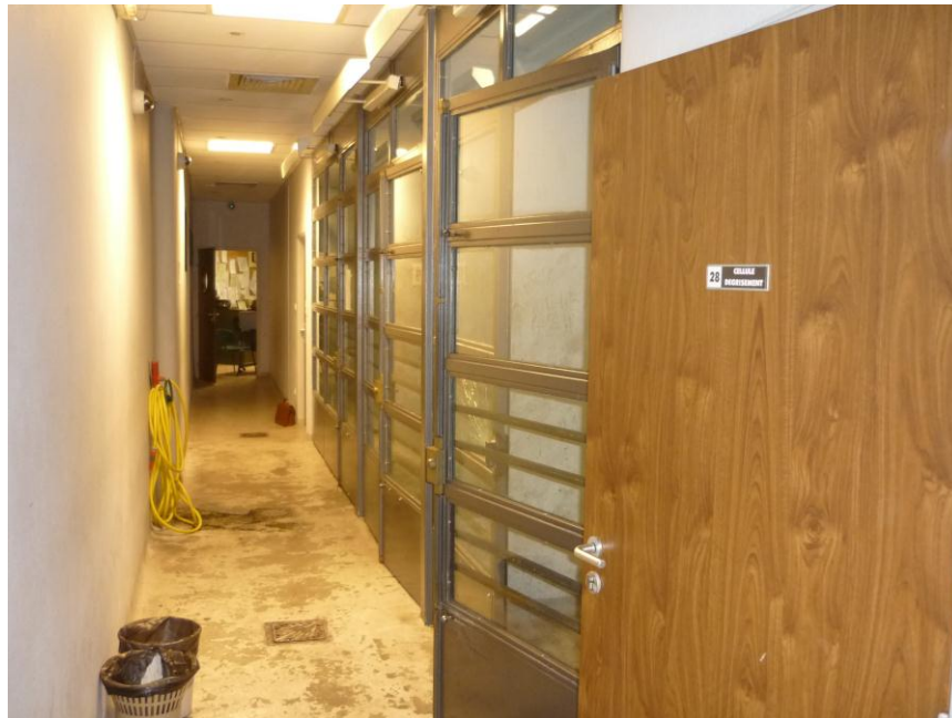
Couloir desservant les cellules de garde à vue
