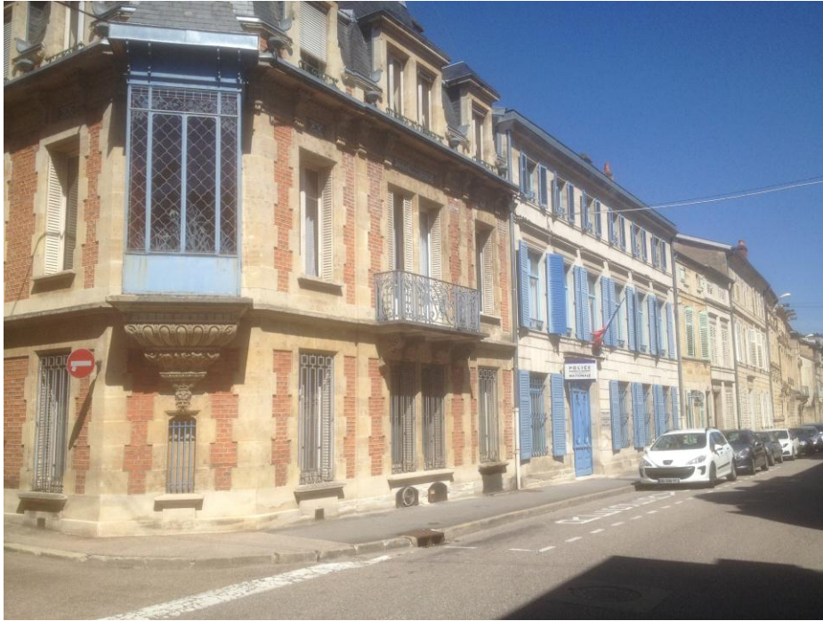
Les façades, côté rue du Bourg, des deux immeubles bourgeois qui accueillent le commissariat de Bar-le-Duc.
