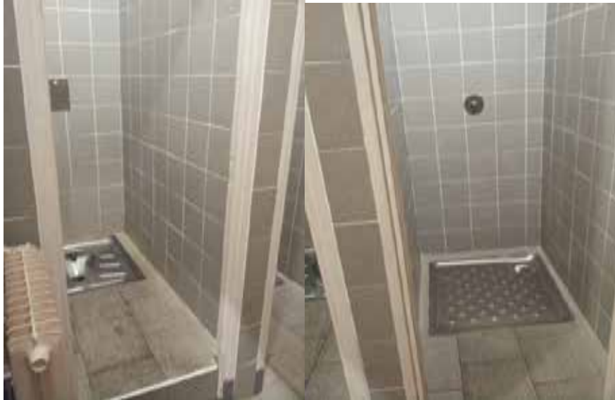
WC dans le local de gauche
