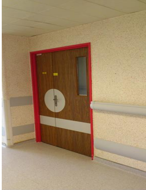
Portes des chambres sécurisées donnant dans le couloir du service
