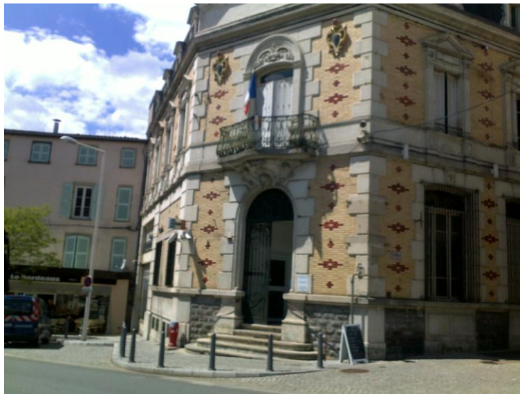
Le bâtiment de la gendarmerie vu de l'extérieur
