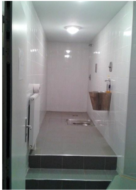
La salle d'eau
