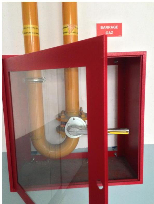
*Le coffret de protection de la vanne d'ouverture du circuit de gaz*
