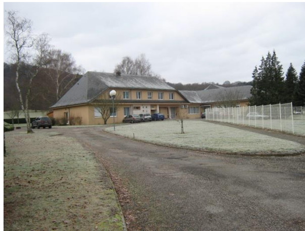
Vue extérieure du bâtiment
