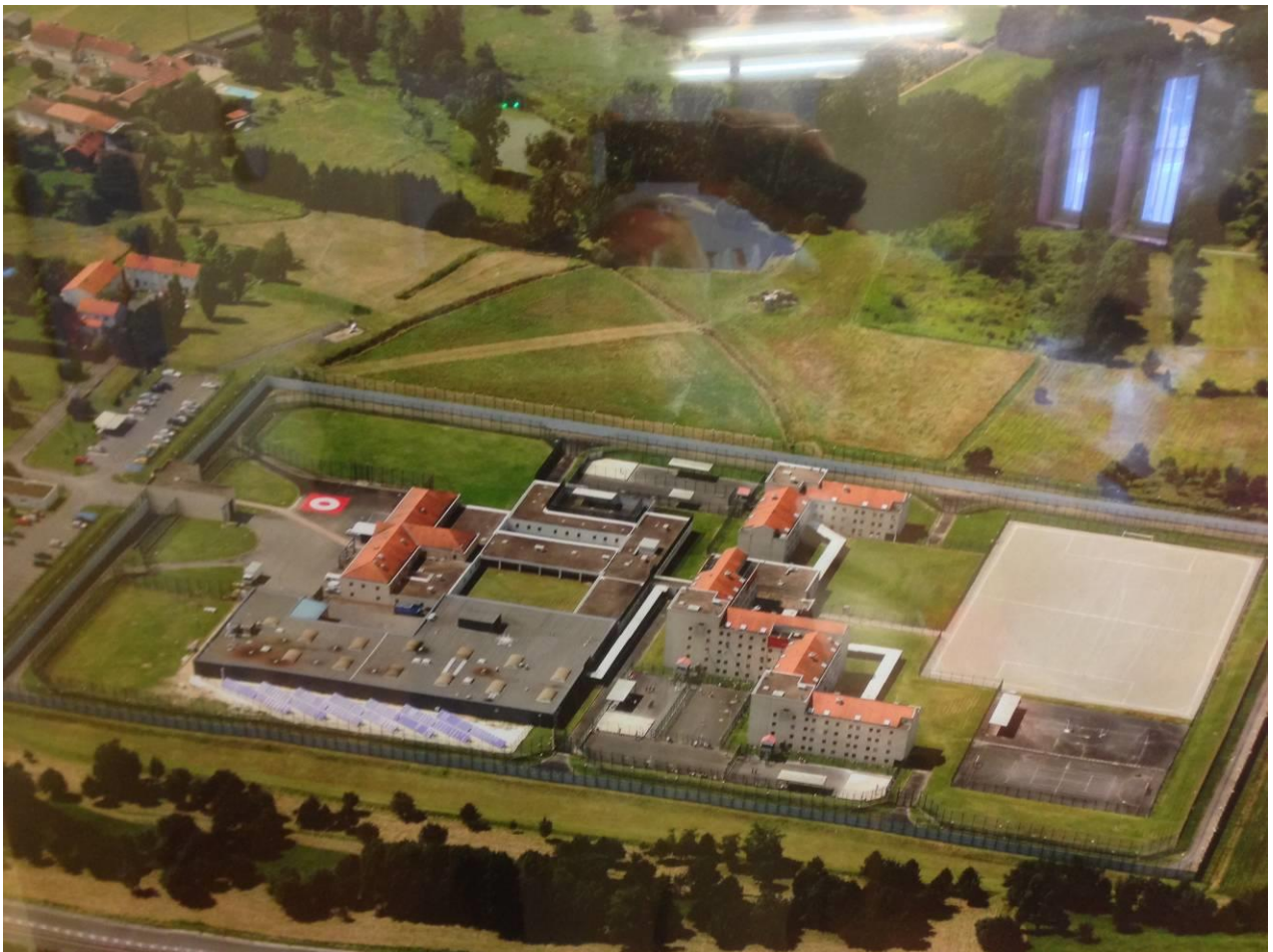
Vue aérienne du CD de Neuvic prise avant les travaux (UVF et SPIP)
