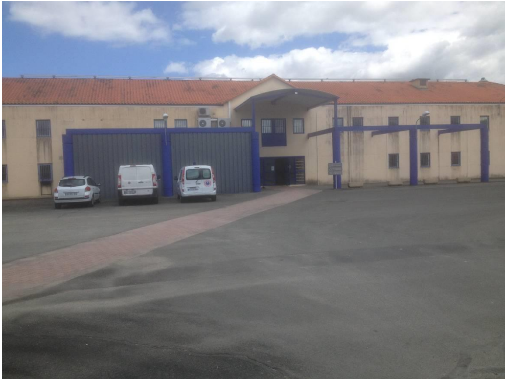
Le bâtiment administratif, côté cour d'honneur.
