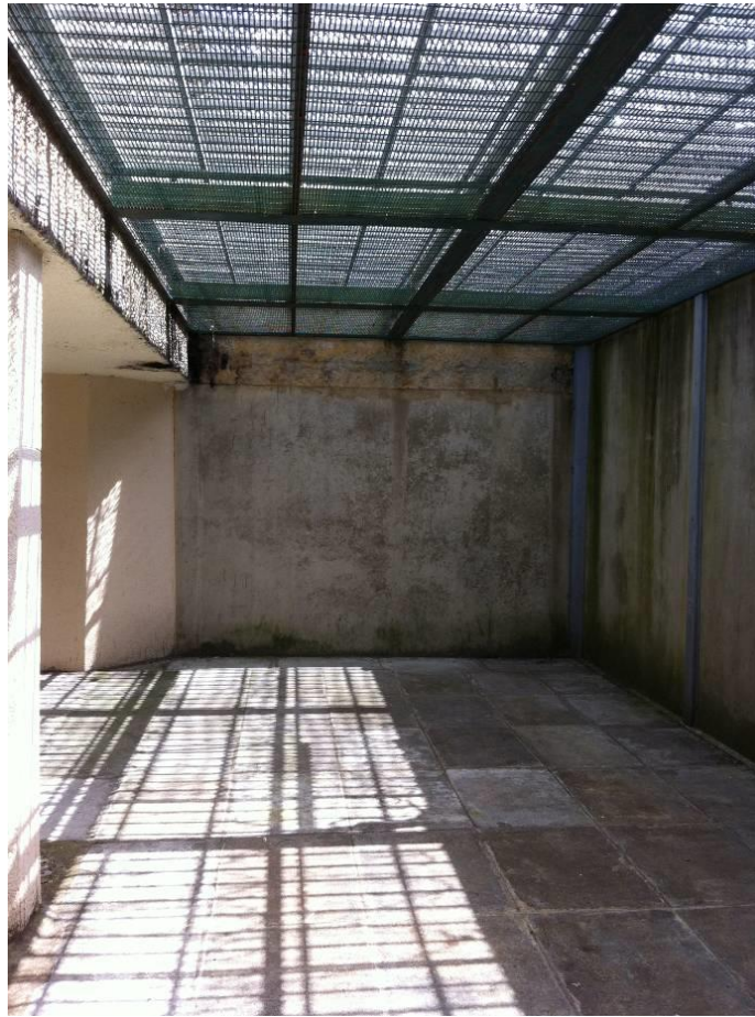
Une des cours de promenade du quartier disciplinaire
