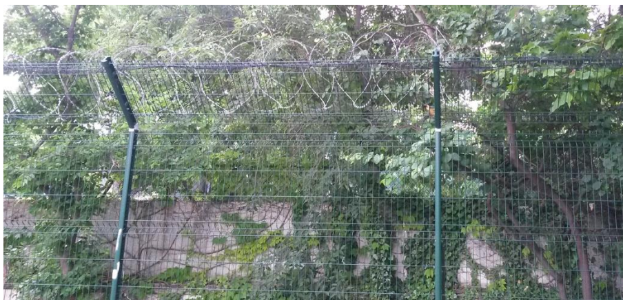
Partie du grillage surmontée de « concertinas »
