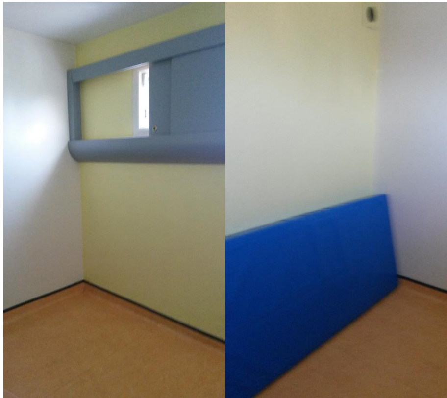
Chambre d'isolement avec fenêtre Matelas posé contre le mur de la chambre
