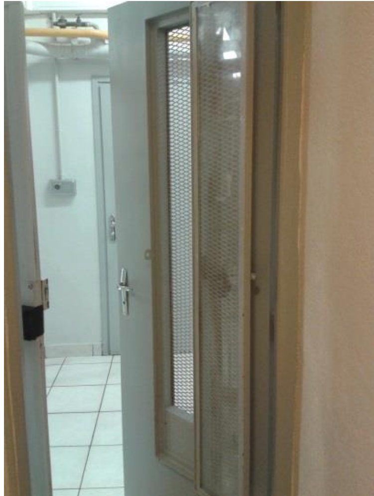
Porte d'une cabine de parloir vue de l'intérieur
