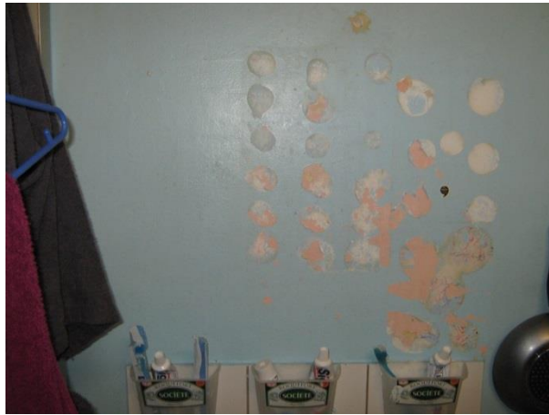
Vue d'une cellule sans miroir
