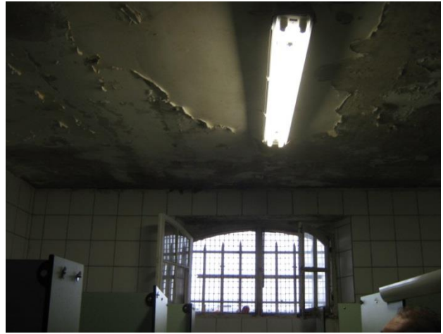
Vues du bloc du 3 ème étage
