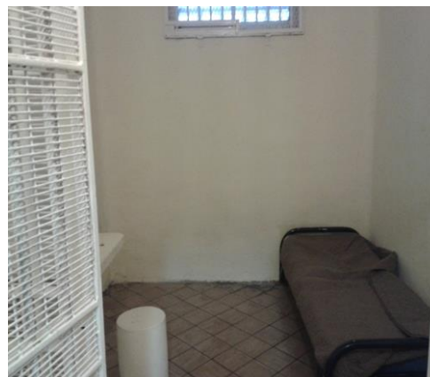
Cellule rénovée du QD
