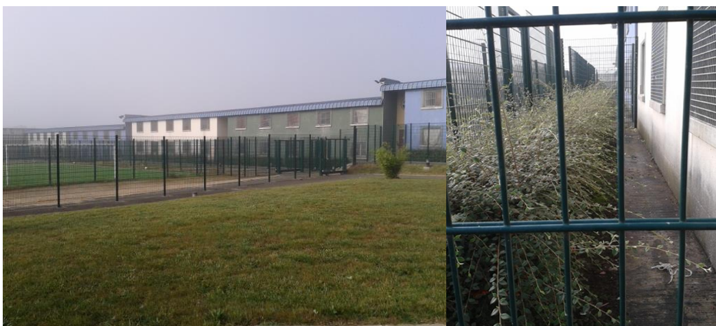
A gauche, vue générale. A droite, l'espace entre les fenêtres des cellules et le grillage
