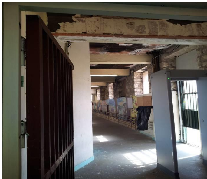
Vue d'un couloir dans le secteur des activités
