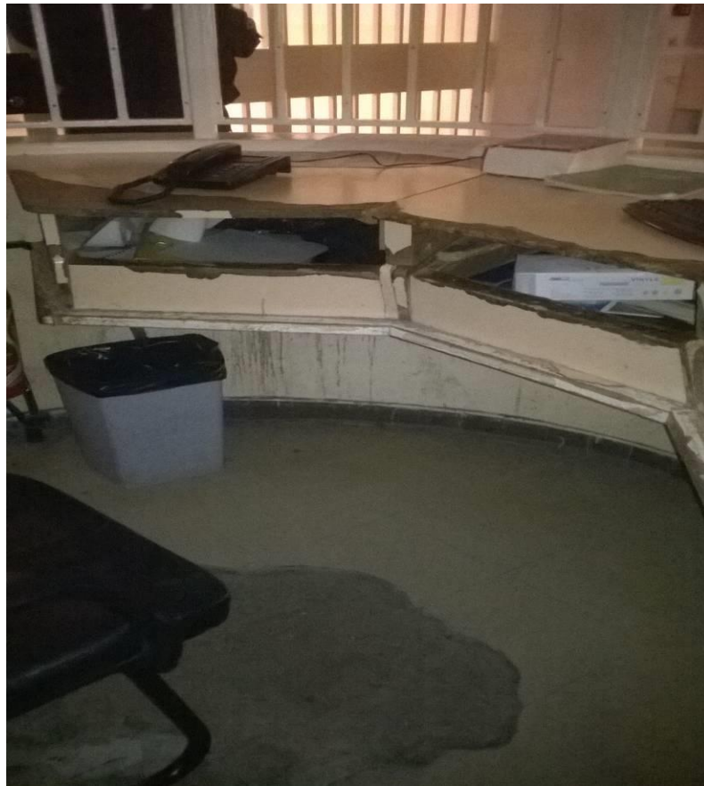
Vue du poste de surveillance à l'étage du bâtiment d'hébergement
