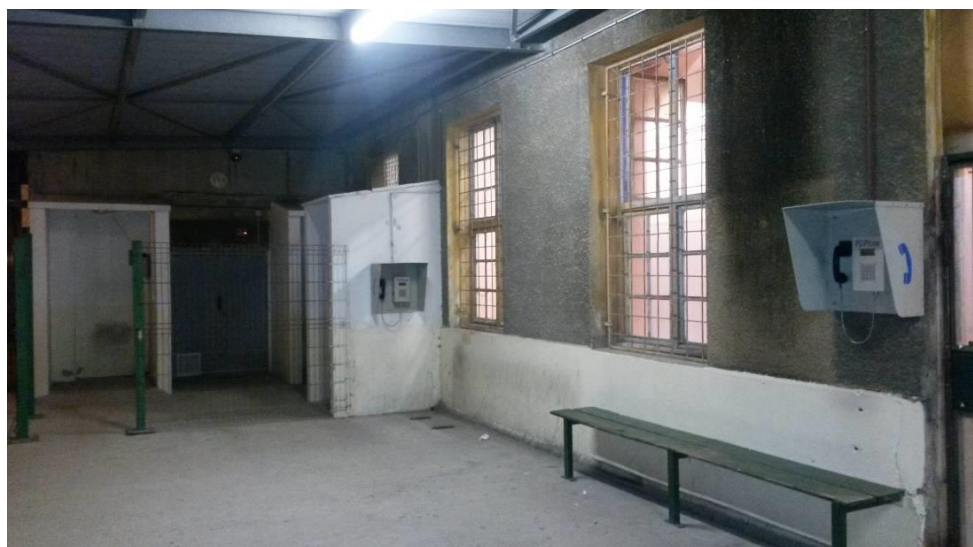
Vue des postes téléphoniques de la cour n°2
