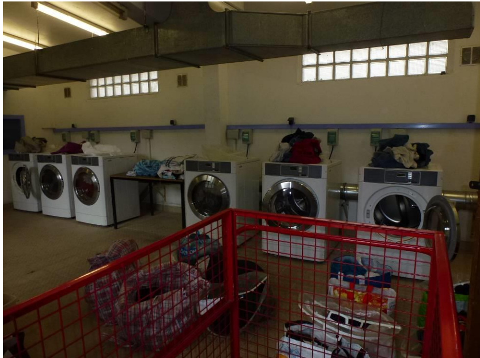
Vue de la nouvelle buanderie
