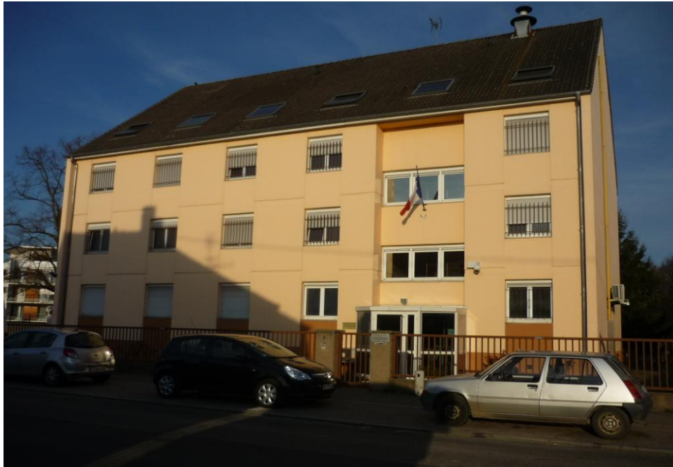
Façade du centre de semi-liberté
