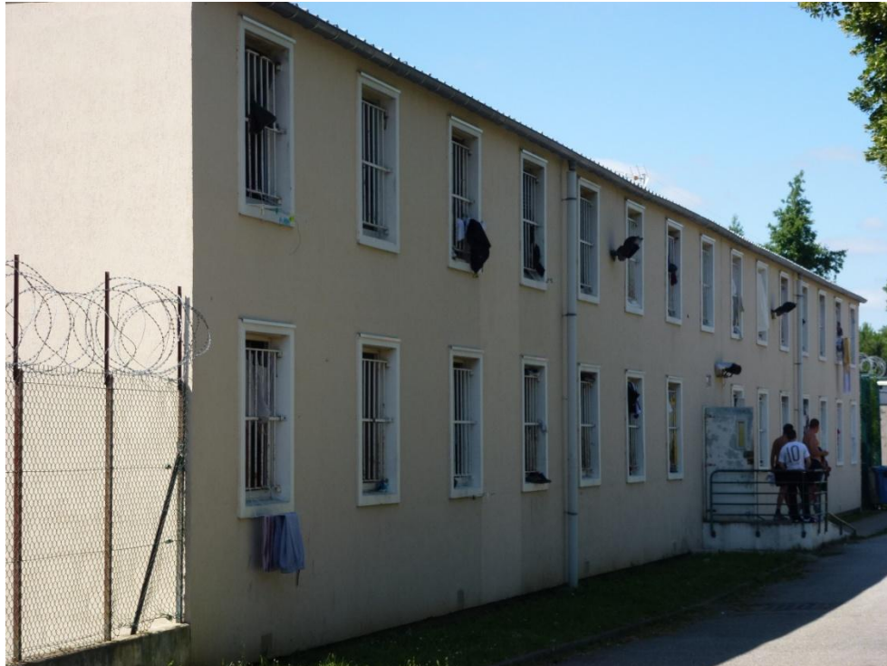
Bâtiment de détention
