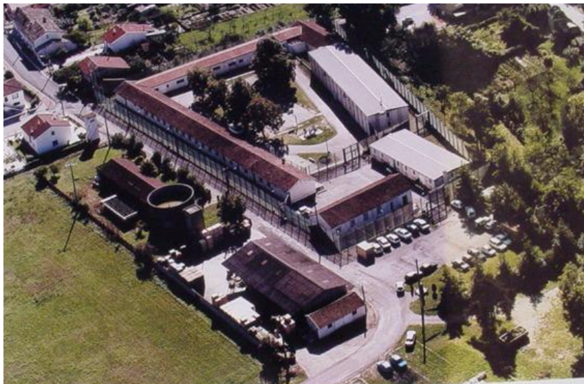
Vue aérienne du CD de Saint-Sulpice-la-Pointe (sans le bâtiment récent comprenant les vestiaires)
