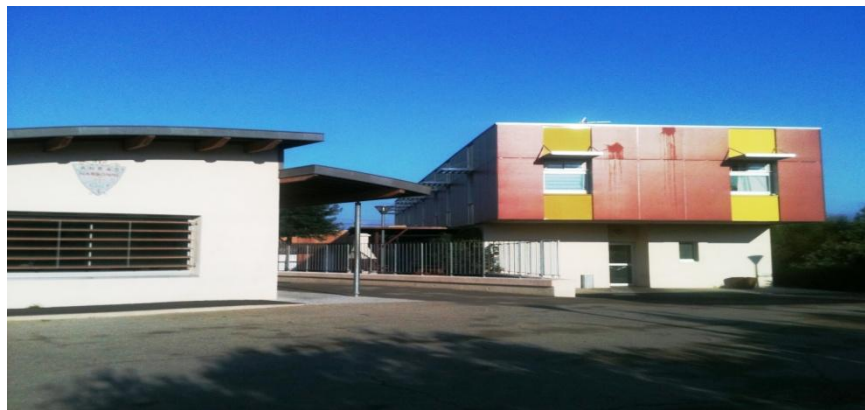
A gauche, le bâtiment administratif, à droite, l'hébergement
