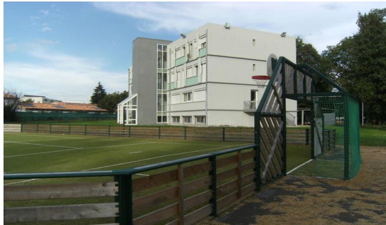
L'arrière du bâtiment (avec l'ascenseur PMR), vu du terrain de sport
