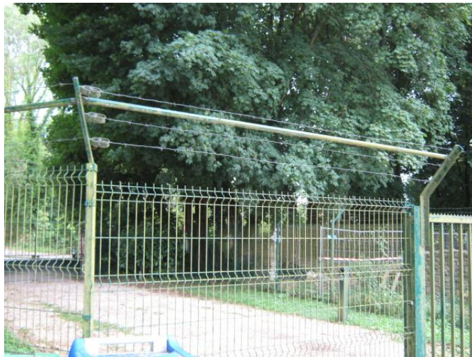
Dispositif de protection du portail d'entrée avec fils de fer barbelés rentrant
