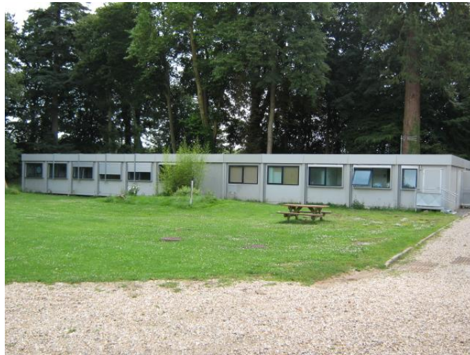
Vue du bâtiment modulaire provisoire
