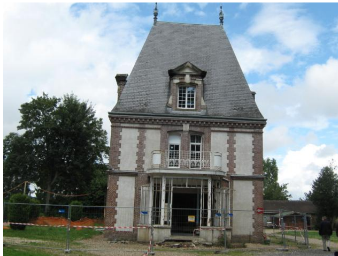
Vue du château en cours de réhabilitation
