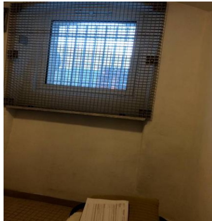
Vue de la grille de caillebotis à l'intérieur d'une cellule disciplinaire
