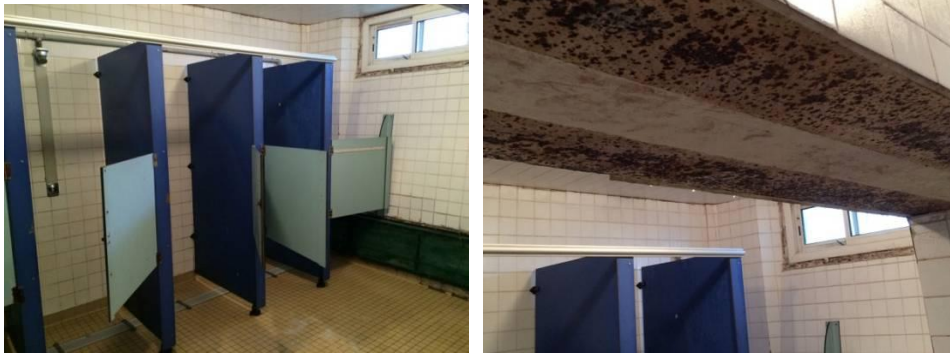
Vue des douches du « grand quartier »
