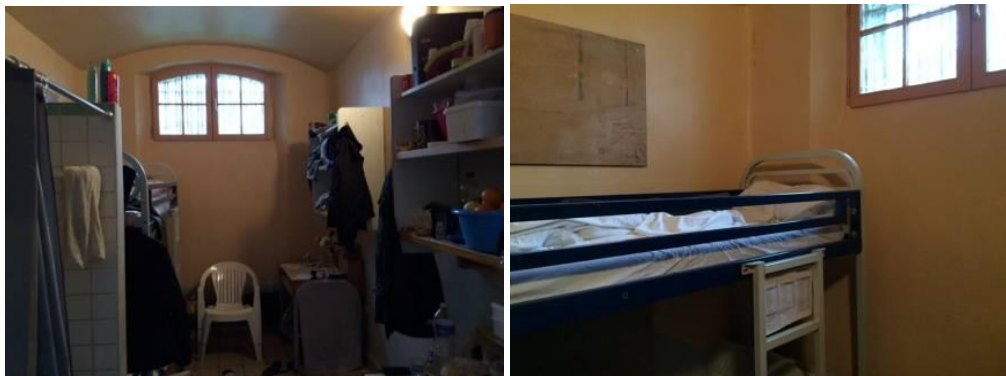
Vues de deux cellules rénovées
