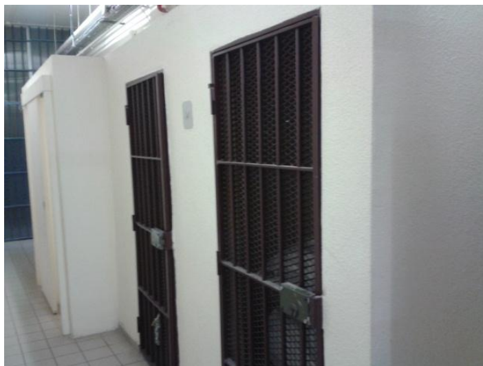
La porte coulissante de la cabine de fouille et les grilles des cabines d'attente
