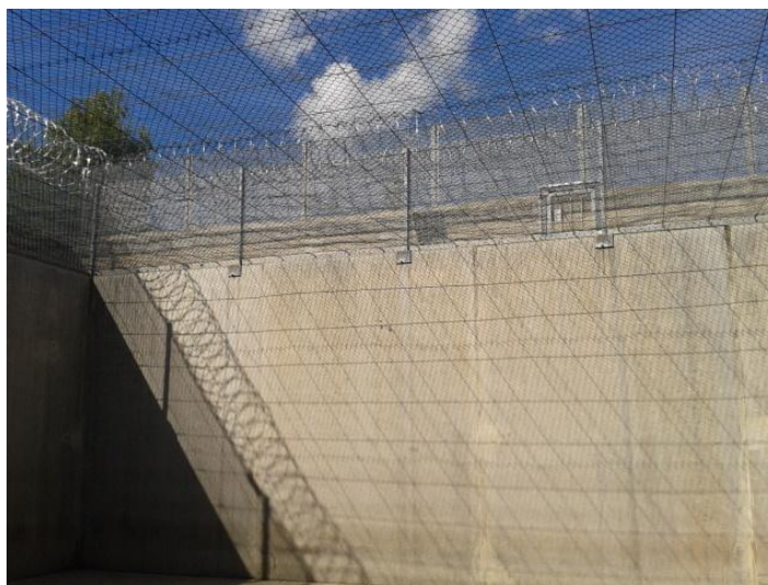
Vues des cours de promenade
