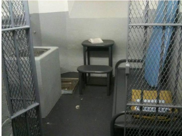
Un lavabo en inox est inséré dans un bloc de béton. Il est alimenté en eau froide par un bouton pressoir. Dans un angle, se trouve un wc à la turque en inox ; la chasse d'eau, commandée par un bouton poussoir, ne délivre qu'un maigre filet d'eau, manifestement insuffisant pour l'évacuation des excréments. Ces installations sanitaires sont sales.
