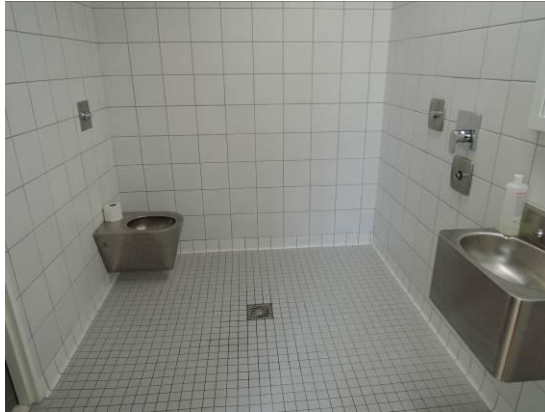
Salle d'eau de chambre d'isolement au SISO
