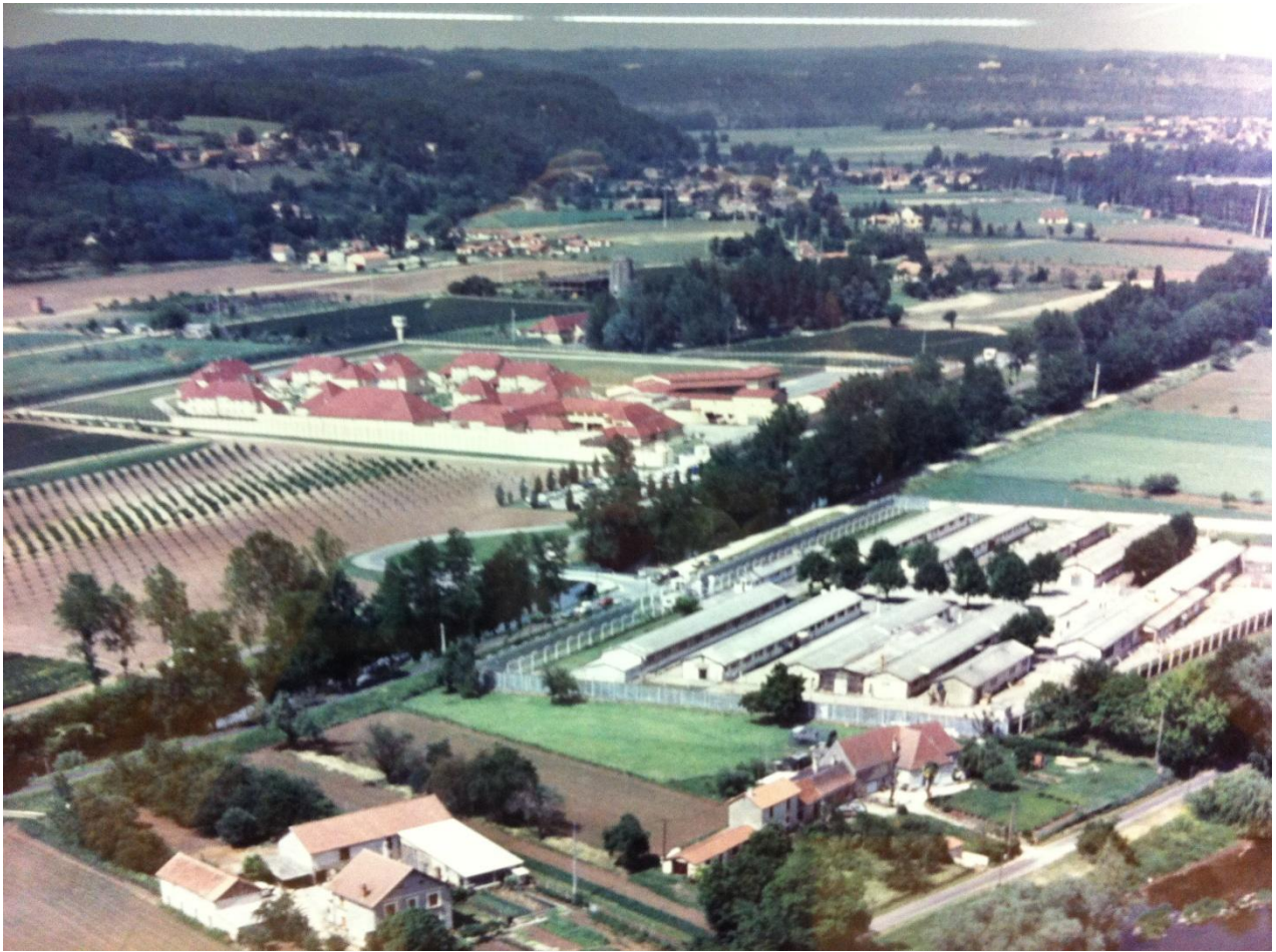
Photo de « l'ancien camp » (1 er plan) avant rénovation et du « nouveau camp » (arrière plan)
