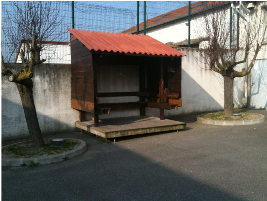
L'abri des fumeurs
