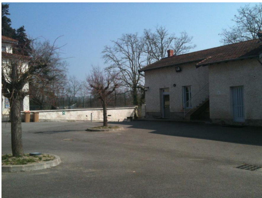
Les deuxième et troisième corps de bâtiment
