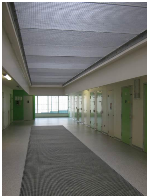
Le couloir du niveau N0 avec les caillebotis au sol et au plafond, communiquant avec les niveaux S1 et N1
