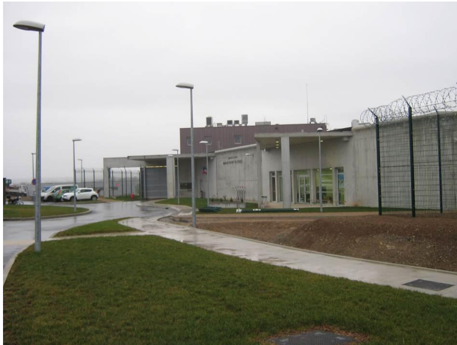
L'accès à la maison d'arrêt
