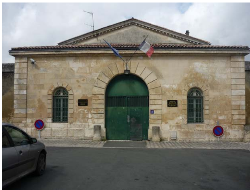
Entrée de la maison d'arrêt de Saintes – vue de l'extérieur
