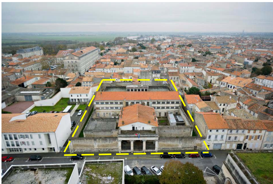
Vue aérienne de la MA de Rochefort, rue du Maréchal Gallieni
