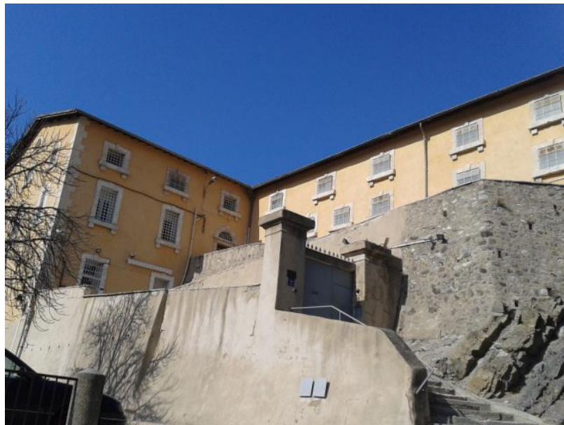
Vue de l'extérieur
