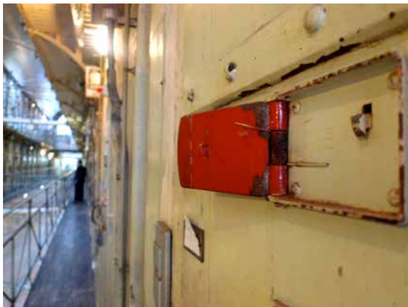
Coursive d'une maison d'arrêt
