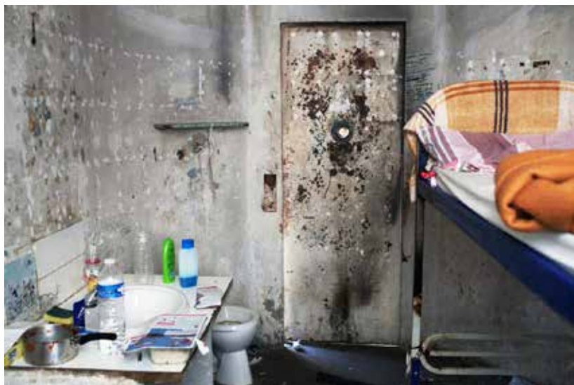
Cellule de confinement de la maison d'arrêt des hommes du centre pénitentiaire des Baumettes à Marseille
