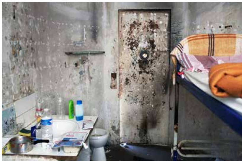
Celda de aislamiento de la prisión para hombres del centro penitenciario "des Baumettes" en Marsella
